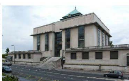
Bibliothèque municipale. Façade sur l'avenue Malraux.
