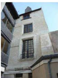
Maison-tour du XIIe siècle, 39 rue Bretonneau.
