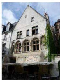
Maison du XIIIe s. du 31 rue Briçonnet.
