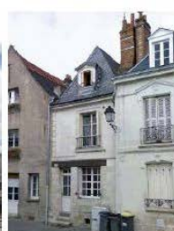
7bis-9 rue Lamartine. Croupe sur rue en remplacement d'un pignon.
