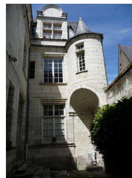
Façade sur cour © Atelier Blanc Duché 2010
