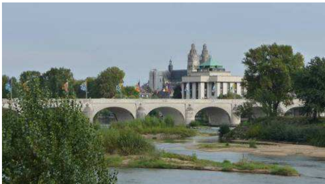
Vue depuis le quai - Fenêtre visuelle permettant de percevoir à la fois le pont Wilson, la bibliothèque et en arrière plan la cathédrale Saint-Gatien
