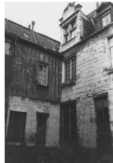
Façades sur cour avant restauration © Inventaire Général 1986
