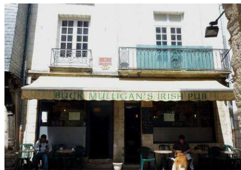
Rue du Grand Marché : stores sur les deux baies de la devanture, à gauche, sur la baie et la porte à droite, trop présents, devant être remplacés par un store par baie, posé dans son emprise
