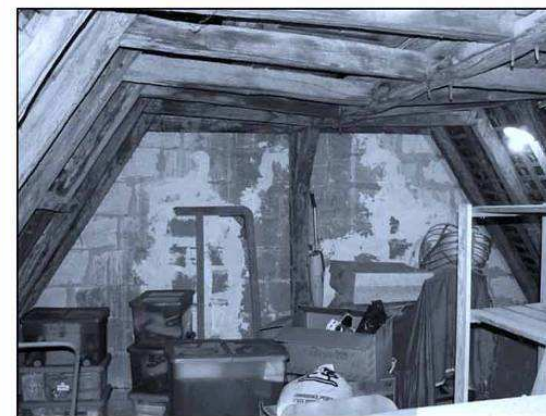
10 rue du général Meusnier. Charpente 2de moitié du XVIe s.
