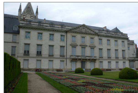
Façade sur jardin de l'édifice du XVIII e siècle (4).
