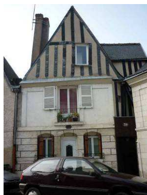
41 rue Jules Charpentier.
