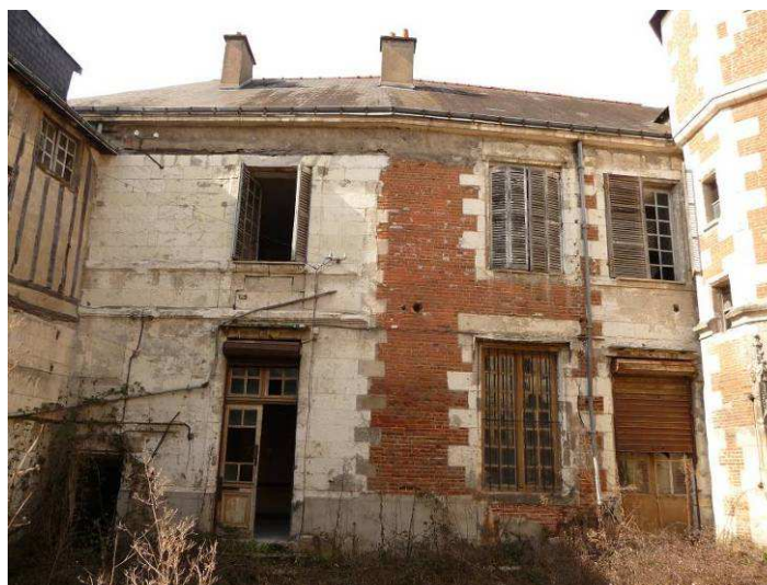
Façade sur cour © Atelier Blanc Duché 2010
