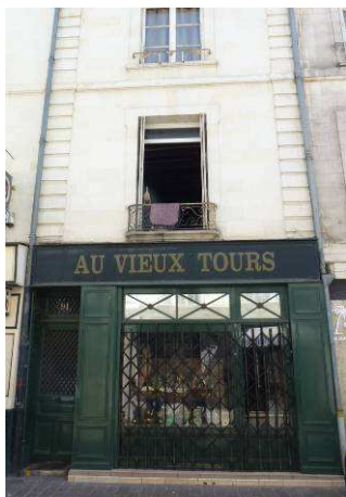
91, rue Colbert : exemple de devanture XIXe, sans doute contemporaine de la façade conservée. Les carreaux multiples des surfaces vitrées ont été remplacés par des glaces. La grille de fermeture a peut-être remplacé des volets repliables dans les coffrages des piédroits.
