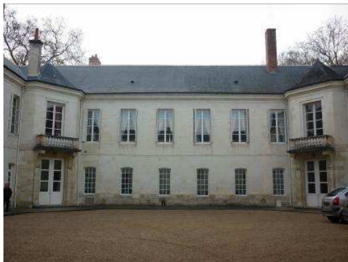
Ancien bâtiment conventuel. Façade nord sur la cour (1).
