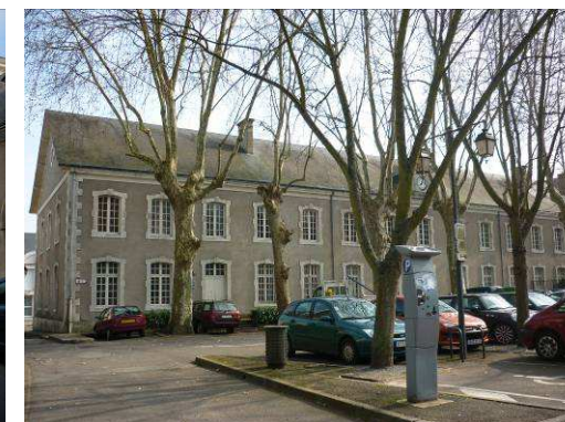
Anciens bâtiments de la caserne Meusnier.
