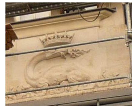
Détail Façade principale en restauration © Atelier Blanc Duché 2010
