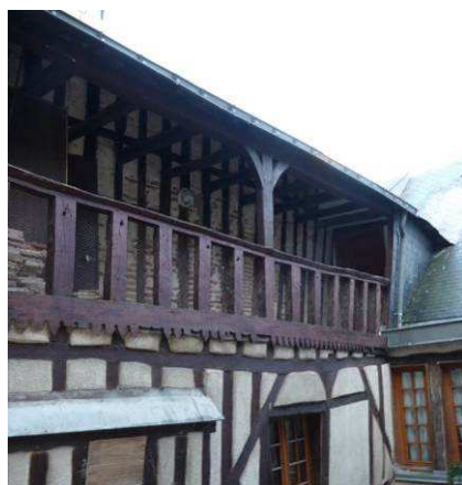
Galerie sur cour © Atelier Blanc Duché 2010
