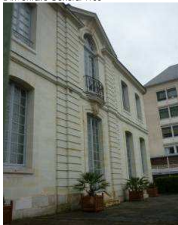
Façade sur cour © Atelier Blanc Duché 2010
