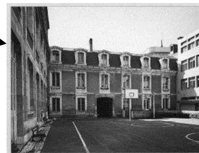
Vue de la cour intérieure : partie de la façade nord de l'aile sud. Phot. Inv. gén.
