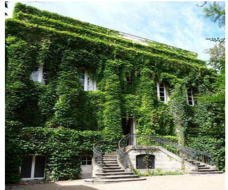
Façade sur cour © Atelier Blanc Duché 2010
