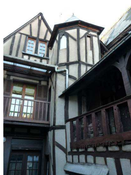
Façade sur cour © Atelier Blanc Duché 2010
