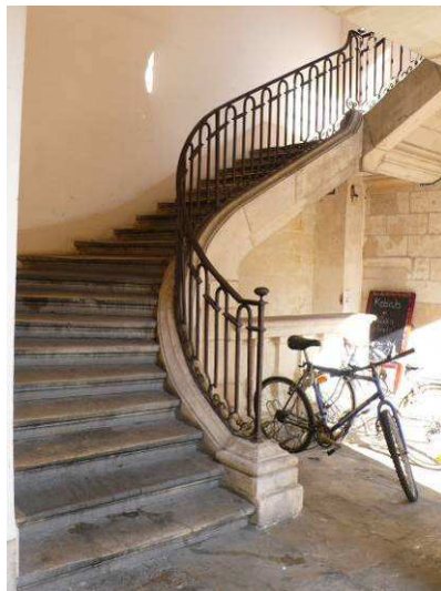
Escalier XVIIIe siècle © Atelier Blanc Duché 2010
