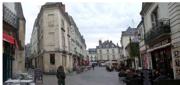
Elargissement de la rue du Commerce et accès à la rue des Orfèvres
