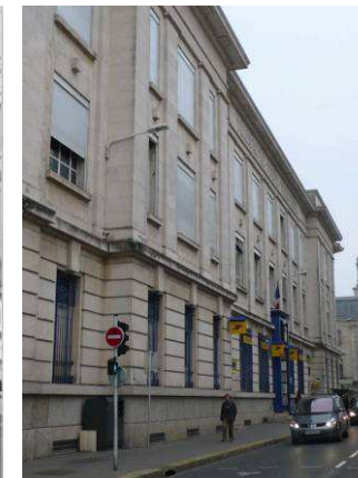
Façade de la Poste. Etat actuel.
