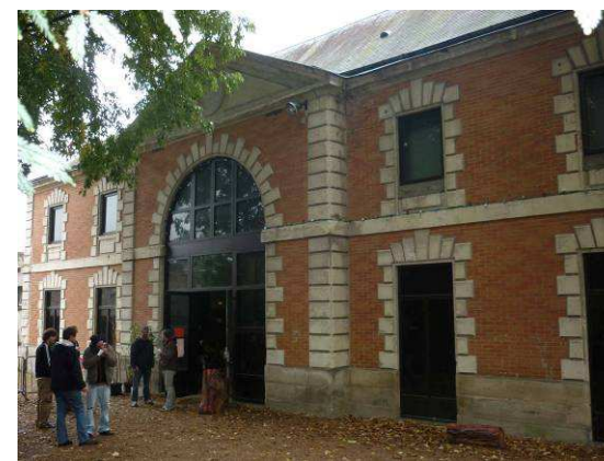
Anciens communs adossés au mur de clôture sud.
