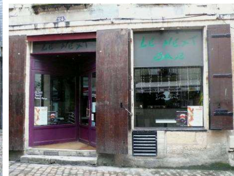
24, rue de la Monnaie : maison dont la façade de pan de bois a été remplacée par une façade de pierre au XVIIIe. Il semble que la maçonnerie du rez-de-chaussée ait été partiellement conservée, en témoigne le soubassement et l'ancien accès de cave. Les baies ont conservé des volets de bois.
