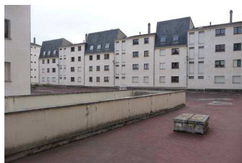
Dalle minérale au sein de l'enceinte formé par les bâtiments – Rue de Ballan
