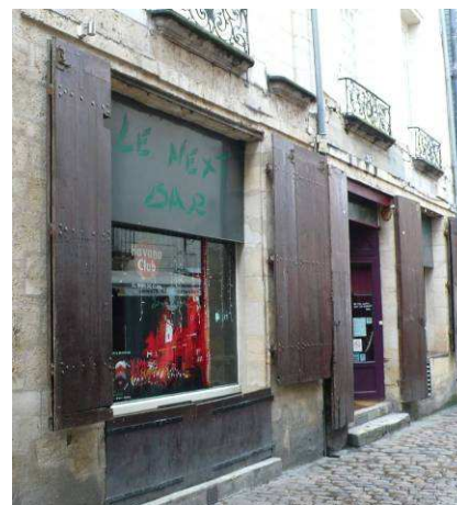
24, rue de la Monnaie : maison dont la façade de pan de bois a été remplacée par une façade de pierre au XVIIIe. Il semble que la maçonnerie du rez-de-chaussée ait été partiellement conservée, en témoigne le soubassement et l'ancien accès de cave. Les baies ont conservé des volets de bois.
