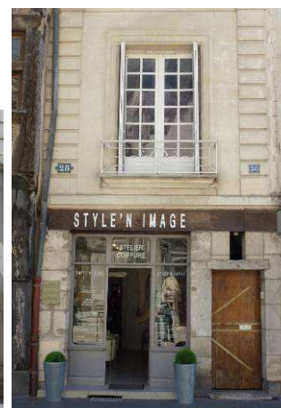
30, rue Georges Courteline : traitement simple et discret. On peut regretter : l'aspect de la porte piétonne
