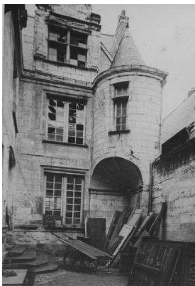
Façades sur cour avant restauration © Inventaire Général 1986
