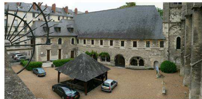
L'ancienne abbaye de Saint-Julien : l'ancienne cour du cloître avec en son centre un pressoir en remploi et au fond l'aile abritant l'ancienne salle capitulaire et le dortoir.
