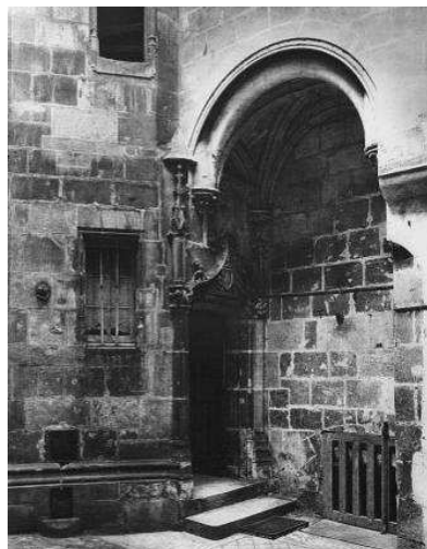
Entrée de l'escalier © Inventaire Général 1986
