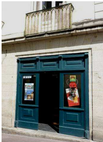
Rue du Commerce : On peut regretter : la faiblesse des parties vitrées et la complexité des panneaux conférant une lourdeur à l'ensemble.
