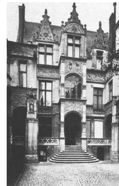
Façade sur cour après restauration © Inventaire Général 1986
