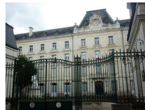
Façade nord du lycée, Vue prise depuis la rue de la Préfecture.
