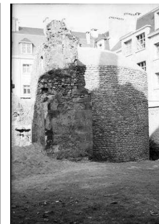
Vue de la tour d'enceinte après consolidation (côté sud), [1951] Fonds Vitry.
