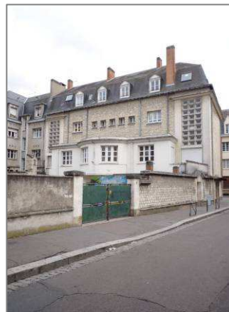
Façade sur cour vue depuis la rue Baleschoux. Phot. Inv. gén. 2010.
