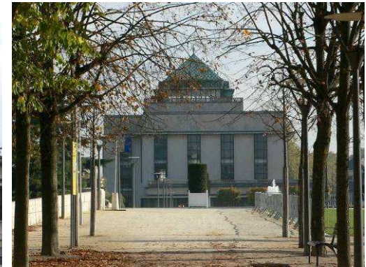
Vue depuis l'esplanade ouest de la place Anatole France.
