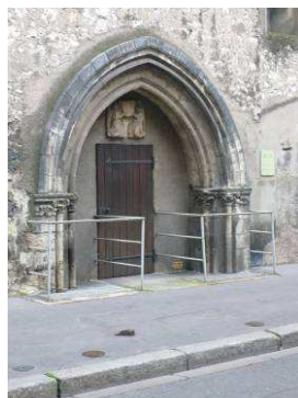
Vestige du portail de l'ancienne église des Cordeliers, sur la façade ouest.
