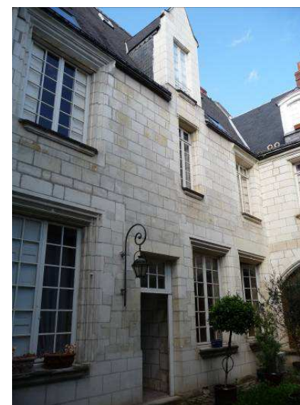
Façade sur cour
