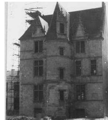
Façades sur jardin après restauration © Inventaire Général 1986
