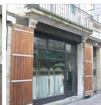
12, rue de la Rotisserie : mauvais exemple de volets récents à planches étroites et régulières, et ferronnerie industrielle
