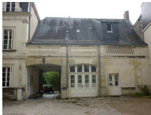
Façade arrière du bâtiment sur rue
