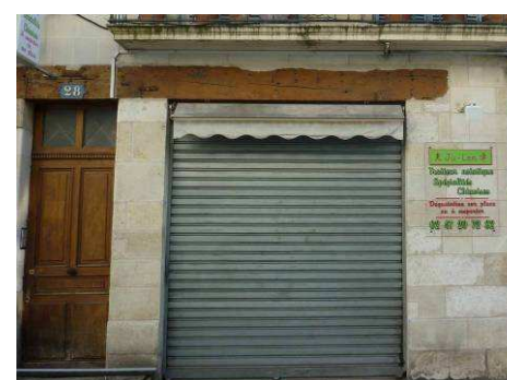
26, rue Bernard Palissy : volets roulants métallique extérieur, coffre intérieur
