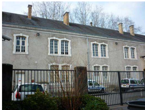
Façade sur la rue des Maures.
