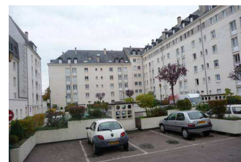
Dalle parking compartimentée par des jardinières aux plantations chétives 3 rue Monseigneur
