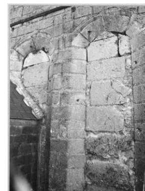
Pignon ouest, vestiges de baies géminées. Phot. Inv. gén. (1983).
