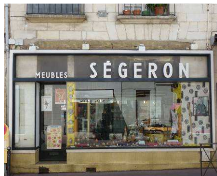
27, rue du Change : devanture années 60 inscrite dans un cadre blanc, à structure de fer noire, seuil et soubassement en carreaux 20x20mm jaunes, imposte en verre armé.
