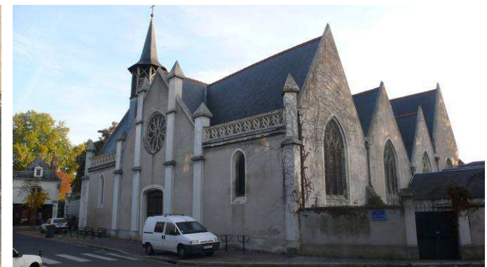
Etat actuel. Façade sur la rue Avisseau.
