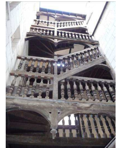
Escalier hors œuvre © Atelier Blanc Duché 2010
