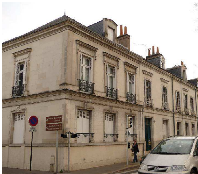
Exemple d'un groupe de maisons formant une composition d'ensemble – 68, boulevard Heurteloup
