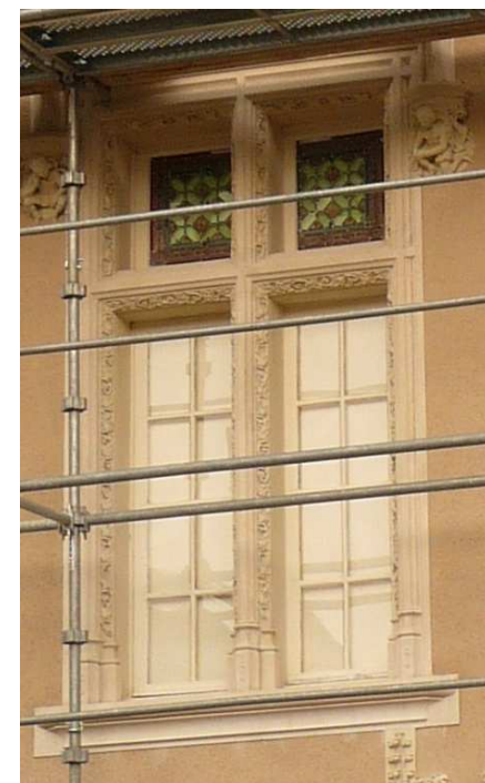
Détail Façade principale en restauration © Atelier Blanc Duché 2010
