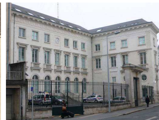
Façades sur la rue Gambetta. Etat actuel.
