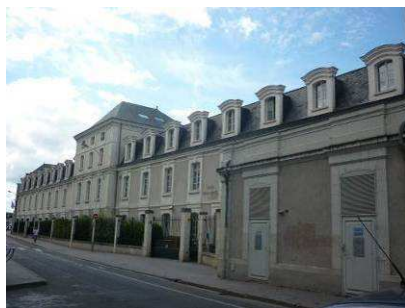
Façade sud du lycée, vue prise depuis la rue des Minimes.
