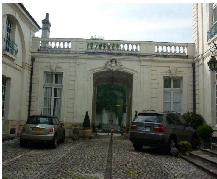
Exemple de cour – 19, rue Emile Zola
