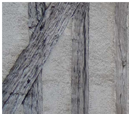
Pan de bois traité de façon sommaire, destiné à être enduit (à partir du XVIIe siècle)
