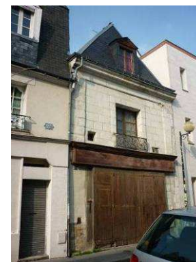
21 rue Jules Charpentier. Croupe sur rue peut-être en remplacement d'un pignon.
