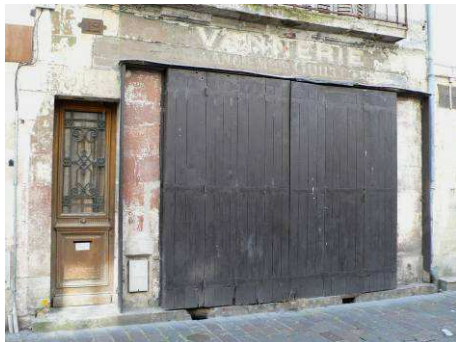
12 et 14, rue des trois Ecritoire : à droite, volets brisés se rabattant sur les piédroits, à gauche, les volets ont été remplacés par une grille extensible posée dans les feuillures des volets
