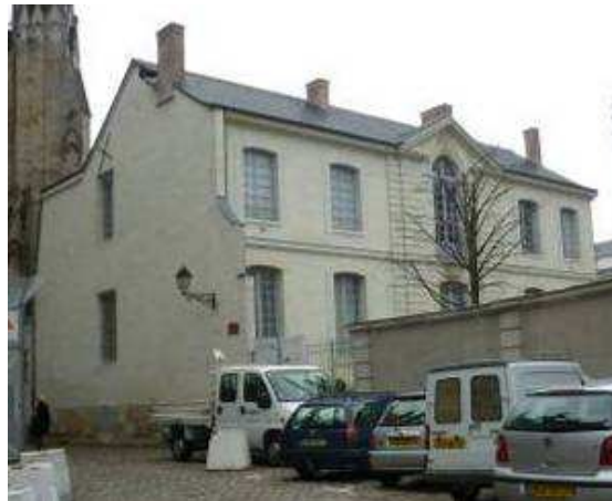
Vue depuis la rue © Atelier Blanc Duché 2010
