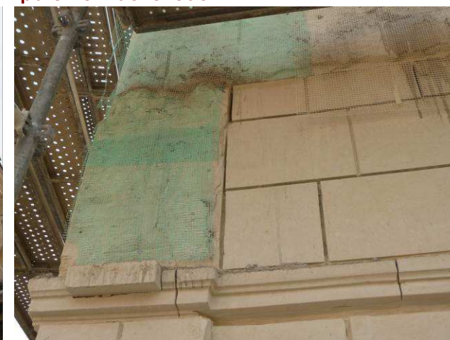
Remplacement du parement sur 5 centimètres d'épaisseur 48, rue N. Destouches
