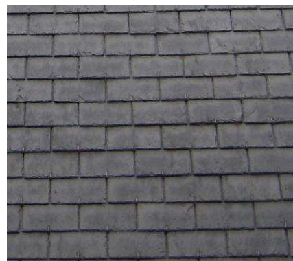
Bardage en ardoise utilisé dès lors que l'ardoise est largement diffusée, pour protéger les façades les plus exposées aux intempéries
