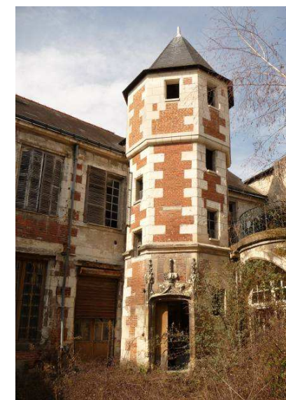
Elévation de la tourelle d'escalier © Atelier Blanc Duché 2010
