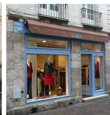
16, rue du Change (refaçaqué XIXe) : châssis bois peints. On peut regretter : la teinte bleue, le store sur la largeur de la façade et le traitement du seuil de l'entrée
