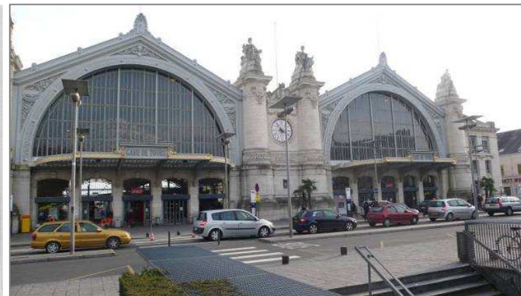
Façade principale de la gare donnant sur la place du Maréchal Leclerc.
