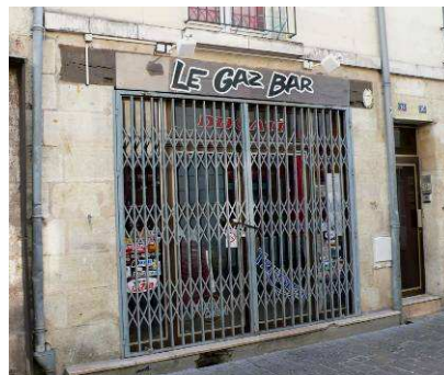
12 et 14, rue des trois Ecritoire : à droite, volets brisés se rabattant sur les piédroits, à gauche, les volets ont été remplacés par une grille extensible posée dans les feuillures des volets
