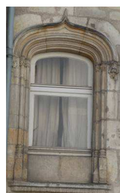
Détail de baie © Atelier Blanc Duché 2010
