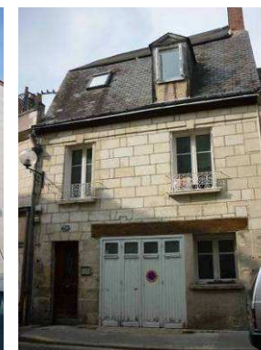
59 rue Jules Charpentier.
