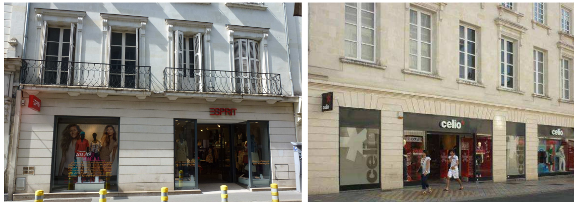
Rue de la Scellerie à gauche et 70 rue Nationale à droite : bons exemples de devantures en feuillure, maçonnerie enduite avec tracé de fausse coupe de pierre ; châssis et enseignes discrets
