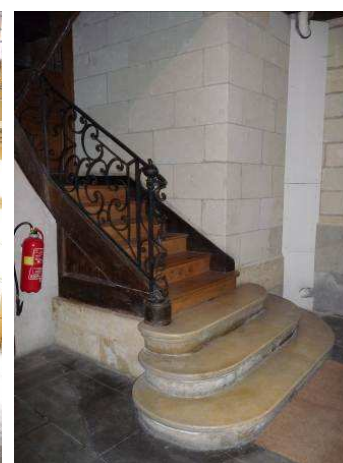
16, rue Littré : amortissement d'escalier du XVIIIe siècle
