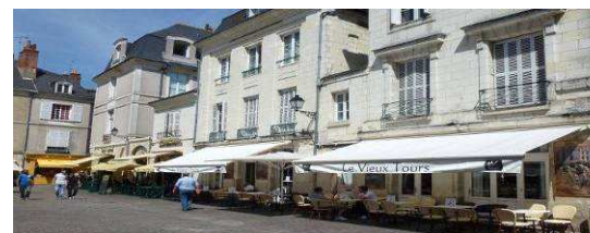
Place Plumereau : la succession des stores banné nuit à la lecture d'ensemble des façades des immeubles. Privilégier les parasols sur un pied simples décollés des façades et en cas d'exposition sud des devantures, une bannière par vitrine posée dans son emprise
