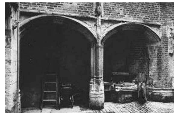
Exemples d'arcades à rez-de-chaussée sur cour
