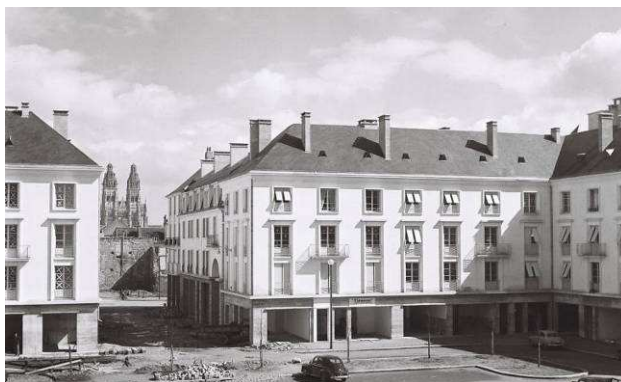
Place de la Résistance vers l'est (îlot M, 1952, André Le Roy, architecte). Le rez-de-chaussée en travaux fait apparaître le rythme des percements des futures devantures commerciales et portes d'entrées des immeubles
