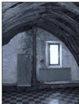
5 rue Manceau. Charpente début XVe s.
