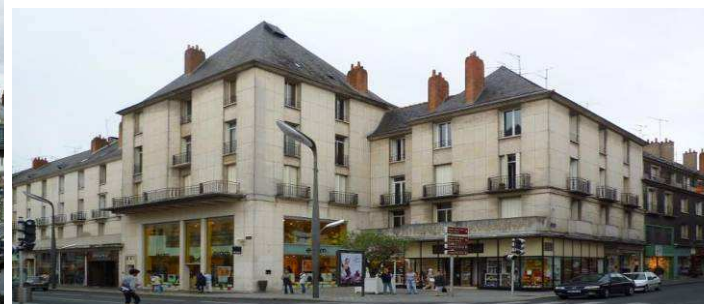
Angle rue Nationale, rue de Halles : devanture sur 2 niveaux sur le pavillon d'angle (traitement moderne avec un seul volume vitré), devanture d'origine de type « boîte » sur l'angle de la rue des Halles
