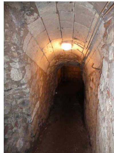
Accès et voûte des caves de l'hôtel © Atelier Blanc Duché 2010
