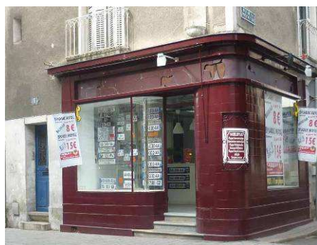
1bis rue Bernard Palissy, angle rue de la Préfecture : devanture années 50
