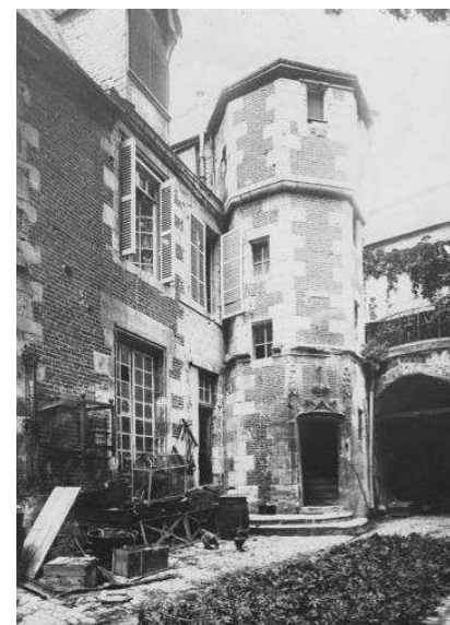
Elévation de la tourelle d'escalier © Inventaire Général 1974
