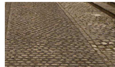
Détail de pavaae – 19, rue Emile Zola
