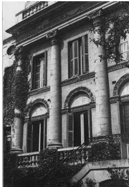
Détail Façade sur cour avant restauration © Inventaire Général 1975
