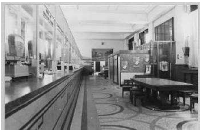
Vue du hall du rez-de-chaussée. Phot. Inv. gén. années 1980.
