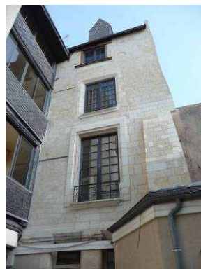
Maison-tour du XII e siècle, 39 rue Bretonneau.
