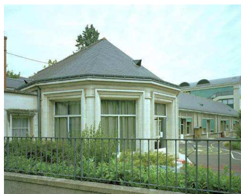
Vue générale de l'école maternelle depuis la rue des Jacobins. Phot. Inv. gén.
