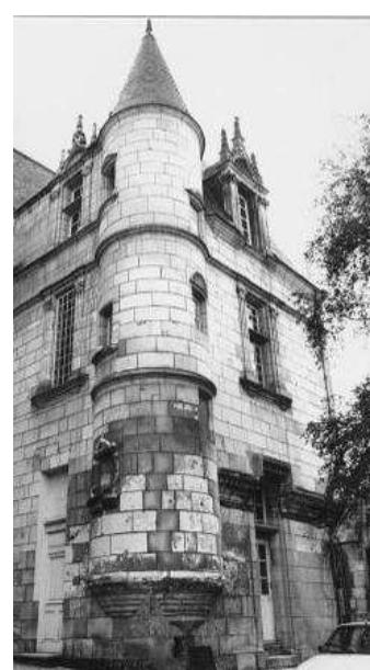
Façades sur cour vers 1914 © Inventaire Général 1986
