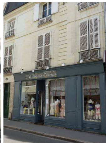
Angle rue du Change, rue XXX : exemple de devanture XIXe, sans doute contemporaine de la façade conservée. Les carreaux multiples des surfaces vitrées ont été remplacés par des glaces. Les volets repliables dans les coffrages des piédroits semblent conservés.
