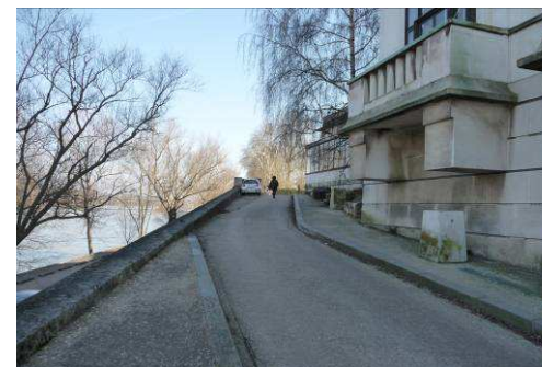
Rampe d'accès aux abords de la bibliothèque
