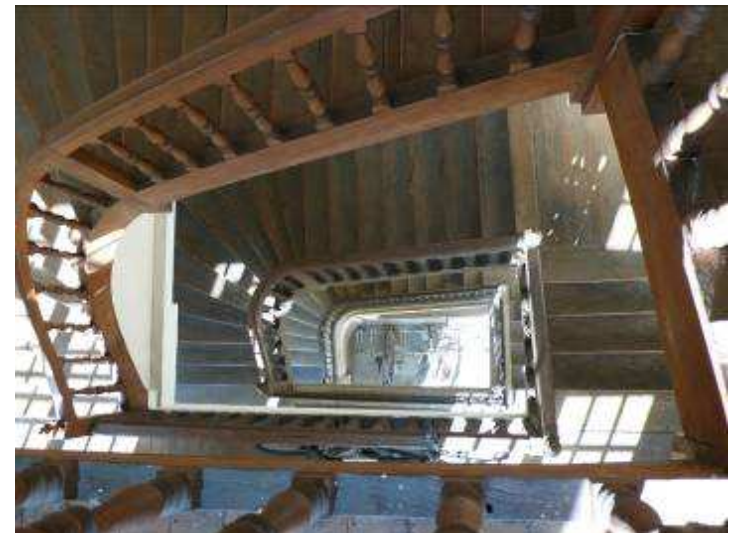
Escalier XVIIIe siècle © Atelier Blanc Duché 2010
