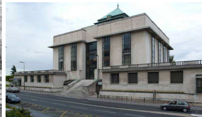
Bibliothèque municipale. Façade sur l'avenue Malraux.
