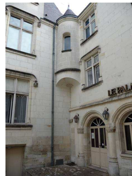
Façade sur cour © Atelier Blanc Duché 2010
