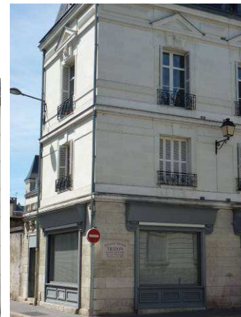
Angle rue Descartes, rue XXX : la devanture est en feuillure et le bandeau en applique. Trois devantures de ce type animent le rez-de-chaussée.
