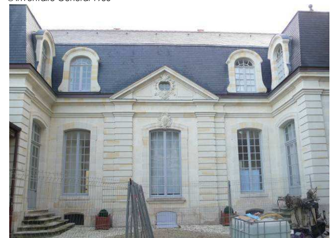
Façade sur cour © Atelier Blanc Duché 2010
