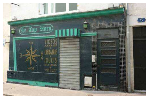
5, rue Jules Charpentier : devanture années 60 en carreaux de faïence 10x10cm et 2x2cm (aujourd'hui) peints, jouant sans doute à l'origine sur 2 teintes. Intégration de la ported'entrée de l'immeuble. Corniche et encadrement de la vitrine en bois mouluré. Pose ultérieure d'un rideau de fer avec coffre saillant.
