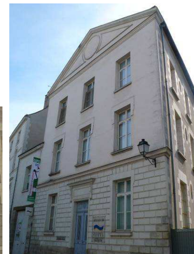
Façade sur rue du museum.
