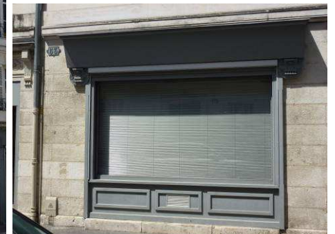
Angle rue Descartes, rue XXX : la devanture est en feuillure et le bandeau en applique. Trois devantures de ce type animent le rez-de-chaussée.
