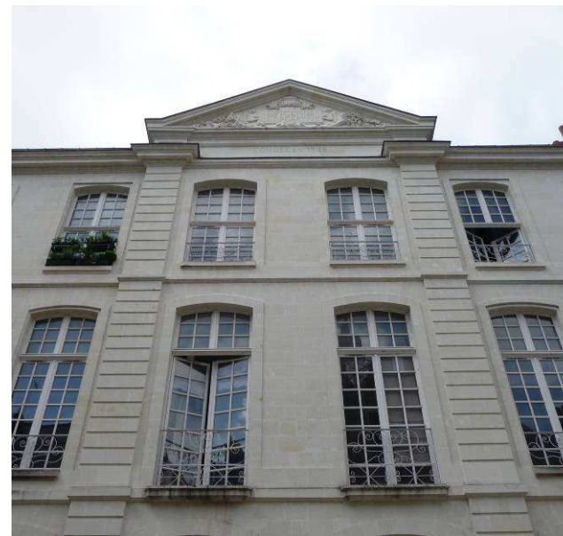
Façade sur cour © Atelier Blanc Duché 2010
