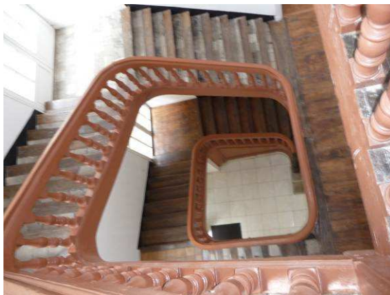
21, rue Briçonnet : cage d'escalier de la fin du XVIIe siècle à jour central
