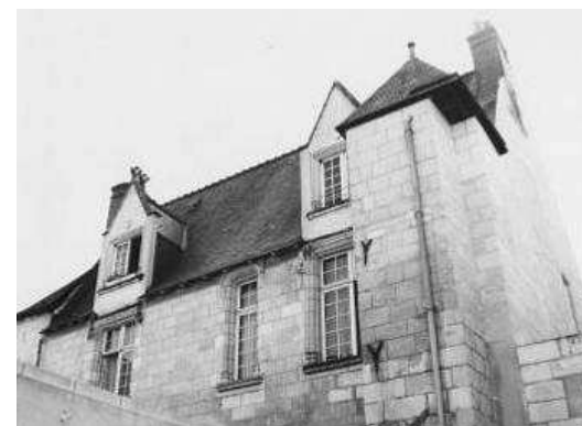
Partie haute de la façade sur jardin © Inventaire Général 1986
