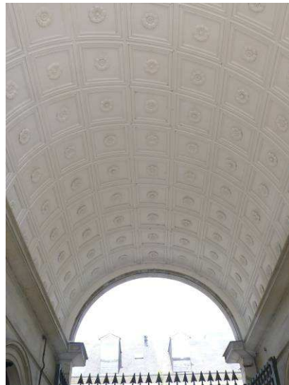
Vue de la voûte à caissons
