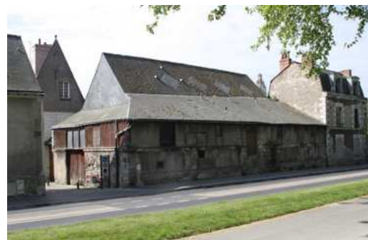
Eglise Saint-Libert : façade nord avant la démolition de l'appentis et de la maison mitoyenne en octobre 2011. Phot. SAT.
