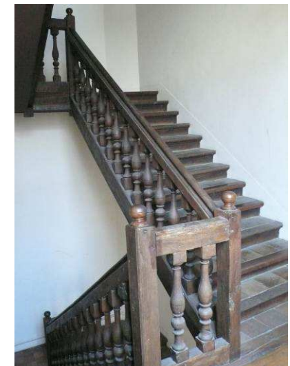
112, rue du Commerce : Escalier à jour central portant de palier à palier, rampe à balustres tournés fin XVIIe siècle
