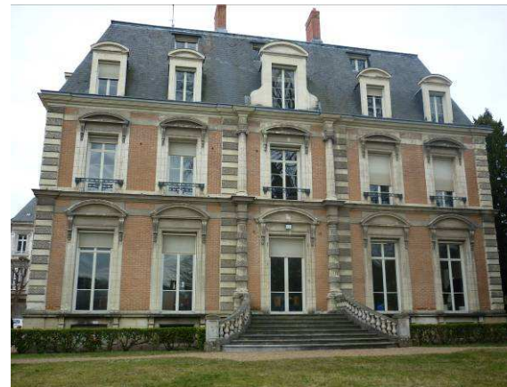
Façade principale © Atelier Blanc Duché 2010
