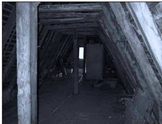
12 rue du général Meusnier. Charpente de comble fin XVe s.
