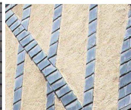
Pans de bois enduit avec essentage en ardoise des bois de structure
