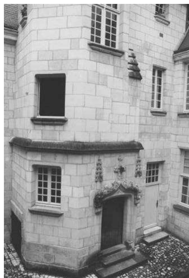
Entrée de l'escalier
