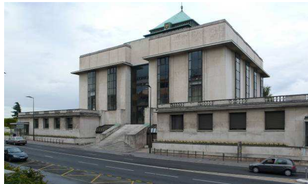
Bibliothèque municipale. Façade sur l'avenue Malraux.
