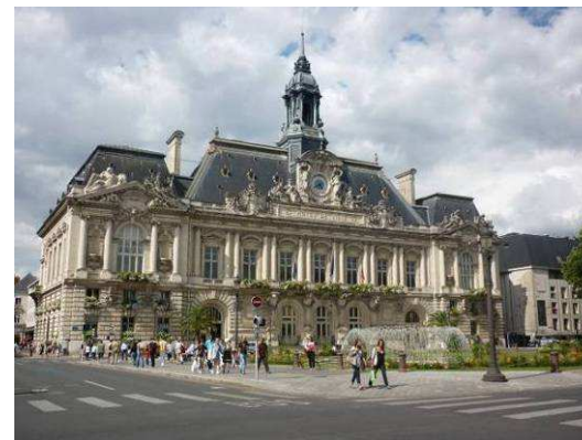
Façade de l'hôtel de ville.
