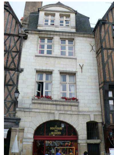
Façade sur rue © Atelier Blanc Duché 2010
