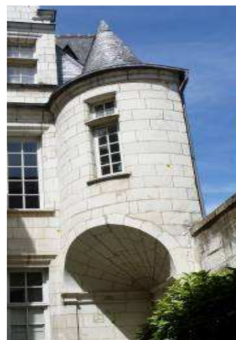
Exemple de tornelle sur trompe
