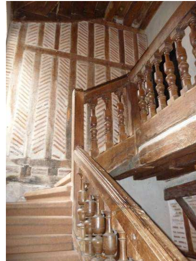
17, rue Constantine : Escalier à jour central (4 noyaux), rampe à balustres tournées du milieu du XVIIe siècle
