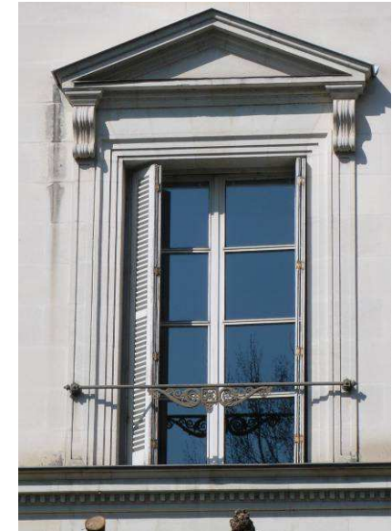
Détail d'encadrement de baie © Atelier Blanc Duché 2010
