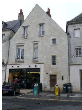
Maison-tour XIII e -XIII e s. 3 place de Châteauneuf et 3 rue du Panier Fleuri.
