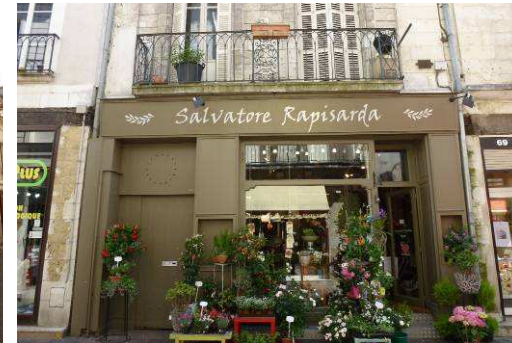
69, rue Colbert : bon exemple contemporain de devanture en applique, intégrant l'entrée de l'immeuble
