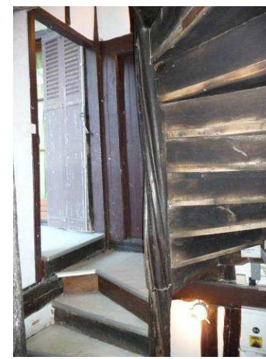
Escalier à vis en bois © Atelier Blanc Duché 2010
