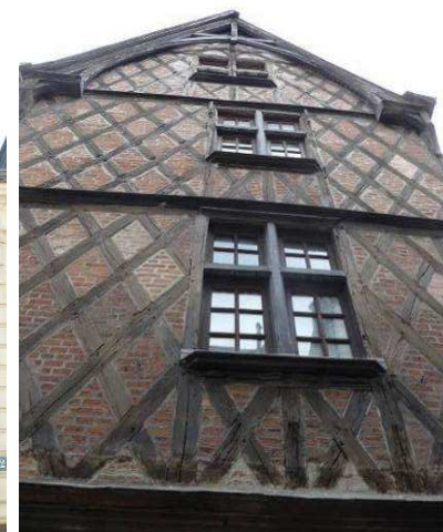
1, place des Carmes : une travée de baies principales
