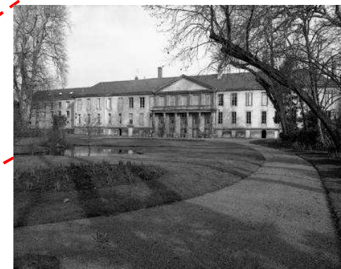
Ancien couvent des Visitandines. Actuellement préfecture. Façade sur jardin récemment restaurée (1). Phot. Inv. gén.
