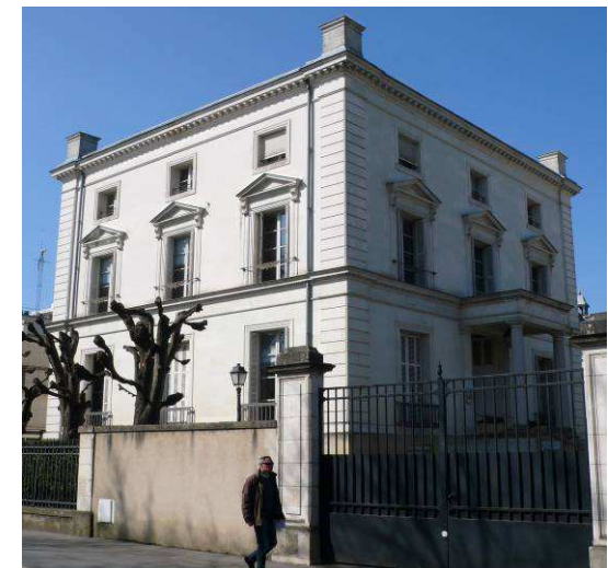
Façades principale et façade sud © Atelier Blanc Duché 2010
