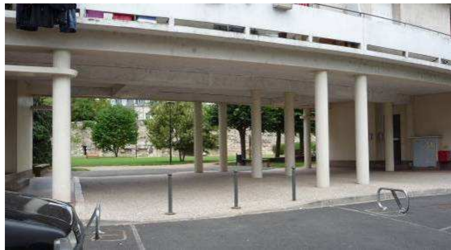
Accès sous porche depuis la rue des Ursulines
