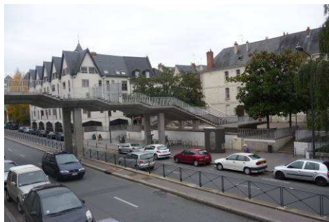
Passerelle de l'université reliée à la place des Joulins et au centre ancien
