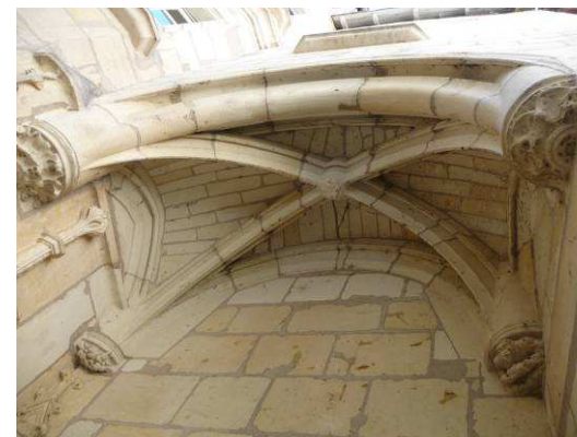
Détail de la voute abritant le seuil de l'escalier © Atelier Blanc Duché 2010
