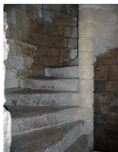
Exemples d'emmarchements d'escalier à vis en pierre
