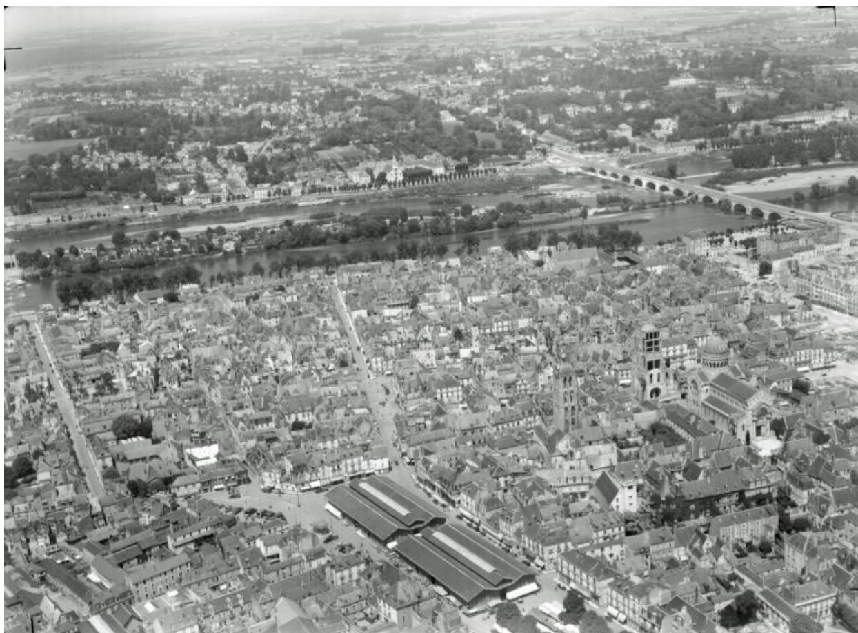
Vue aérienne de Henrard prise en 1949 : partie de la Loire située en aval du pont de pierre, vue prise vers le nord. (N° 1472).
