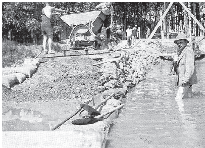
Fig. 17 : Travaux d'assèchement, photo prise entre 1933 et 1939 (cliché Archives munic. de Tours).
