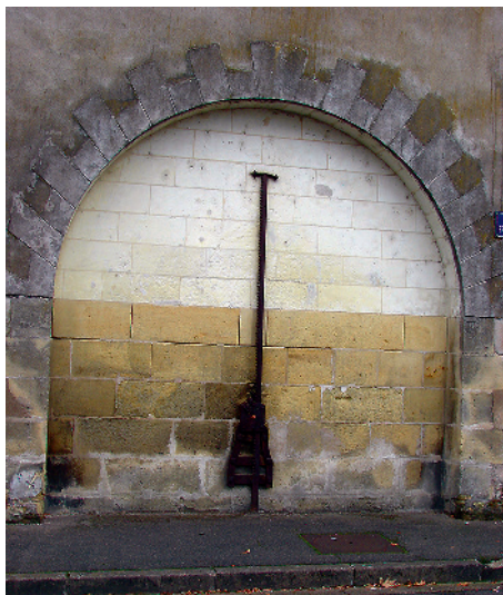
Fig. 15 : La vanne de la rue François-Richer, face au débouché du passage Walvein.
