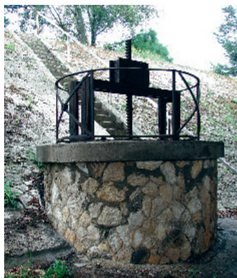
Fig. 11 : La bonde permettant de passer sous le canal Loire-Cher.
