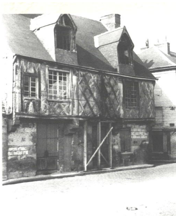
Fig. 18 : Maison du 16 e siècle avant restauration, à l'angle de la rue de Constantine et de la rue de Maillé.
