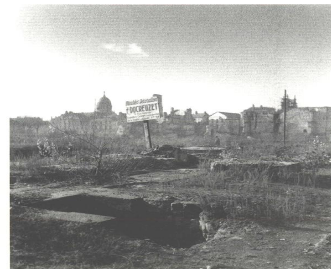
Fig. 12 : Les destructions vues de la rue Nationale.
