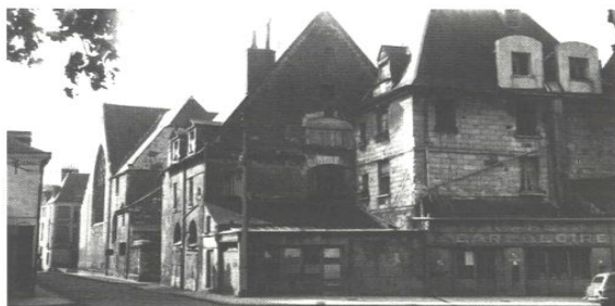
Fig. 17 : L'angle de la rue Paul-Louis Courier et du quai de la Loire avant démolition. A l'arrière-plan l'actuelle église Saint-saturnin, ancienne église du couvent des Carmes, formant aujourd'hui l'angle avec la rue des Tanneurs.
