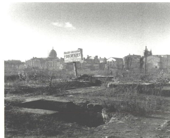
Fig. 12 : Les destructions vues de la rue Nationale.
